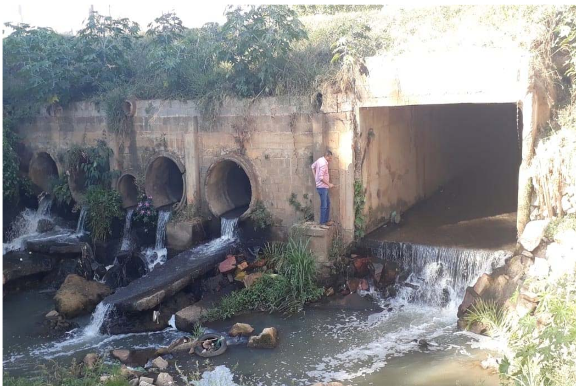
F-02– Est. 45+00 Multiplicidades de Bueiro Tubulares e Celular de concreto, travessia da Avenida das Cerejeiras Localização: Latitude - 18°57'25.34"S Longitude - 46°59'41.07"O.
